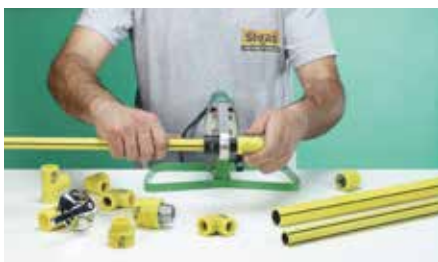
2. Calentamiento del tubo y el accesorio a 260°C
