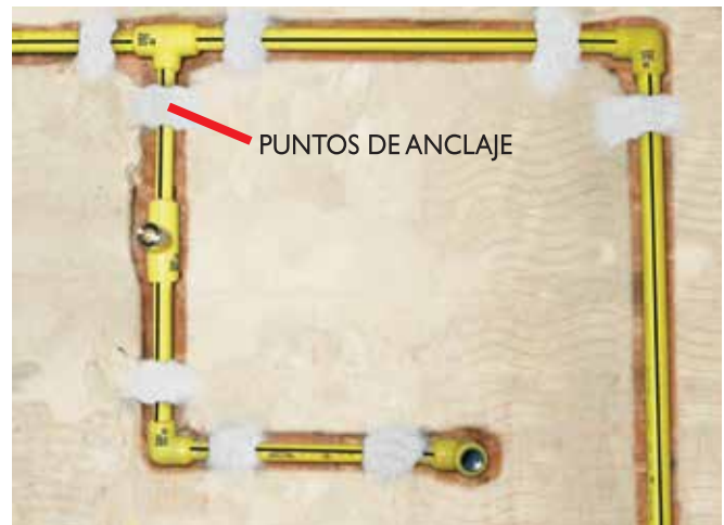
Vista parcial de instalación.
